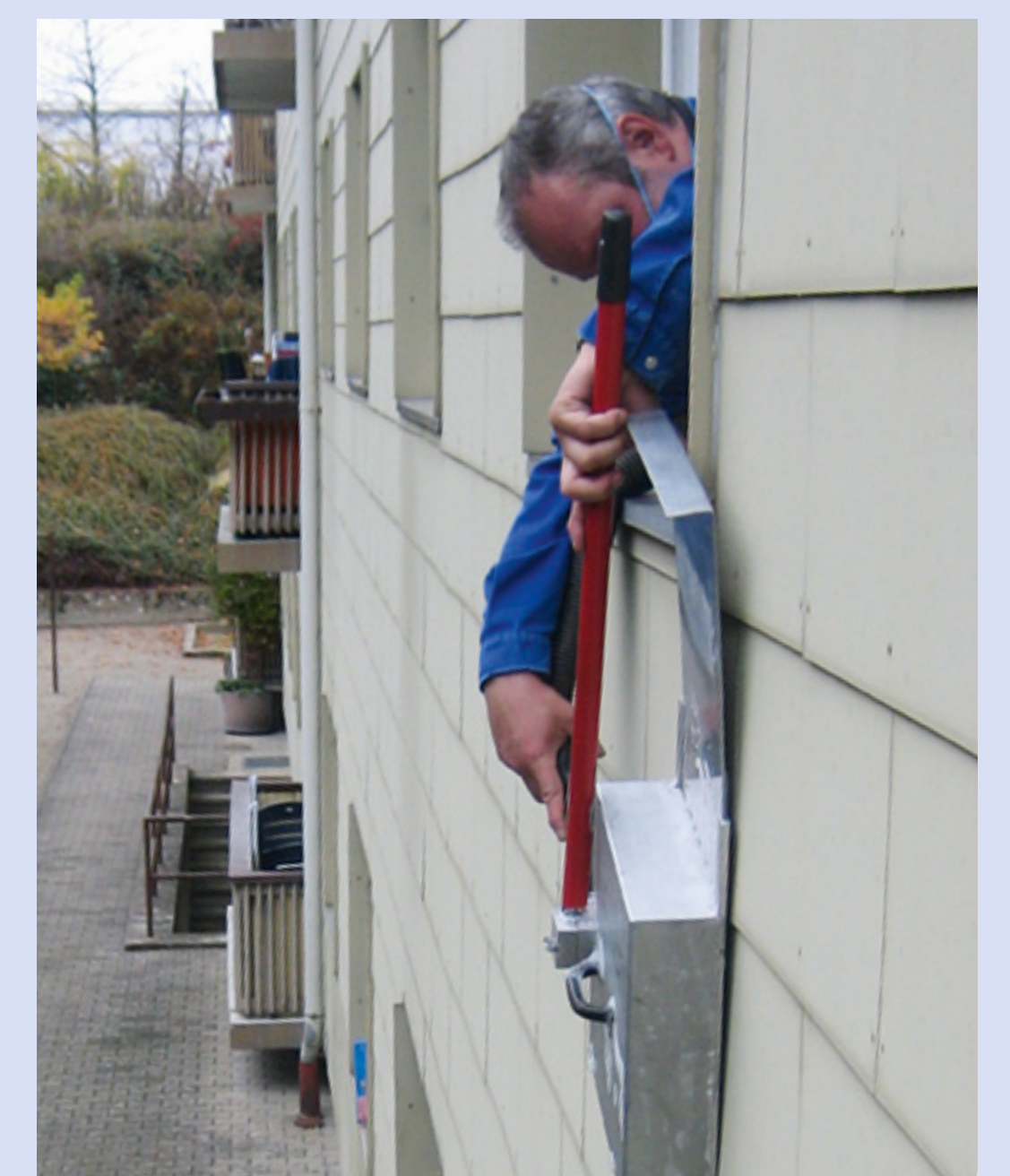
Saugglocke an der Asbestfassade
